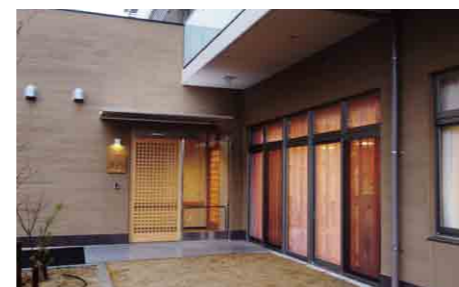
デイサービスセンターきりり 入口
